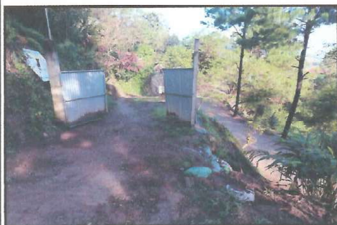
Foto 3: Reparación de Portón.
