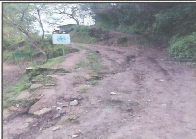
Foto 1: Pavimentación de entrada principal del establecimiento educativo.
