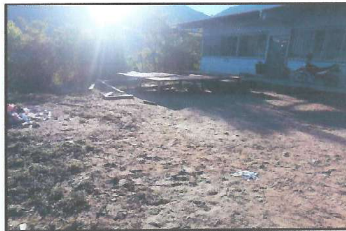
Foto 4: Ampliación y reparación de canales y bajadas de agua pluvial, desembocando hacia la carretera principal.
